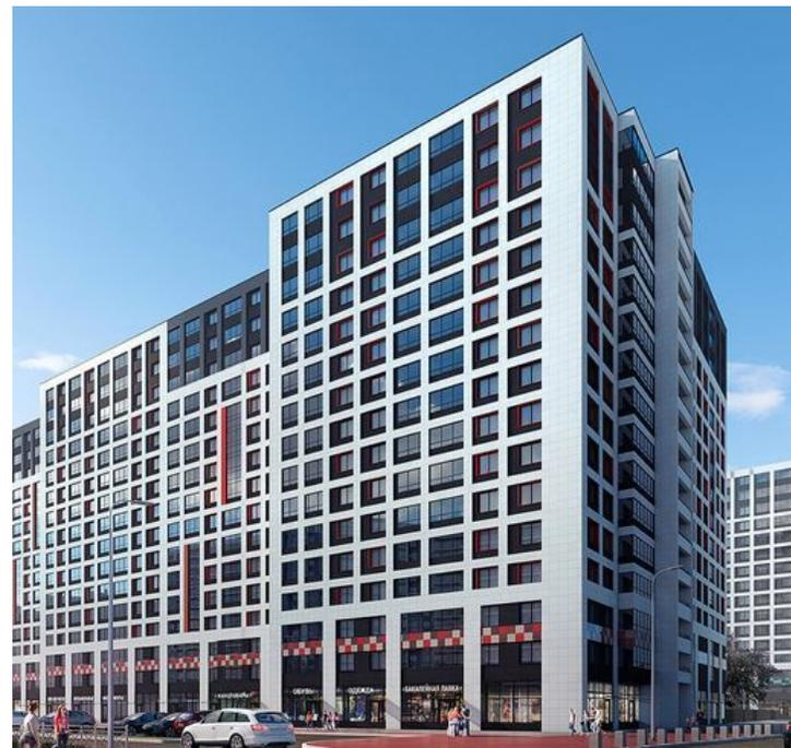
ЖК «Урбанист» состоит из 6 кирпично-монолитных корпусов переменной этажности. Вентилируемые фасады отделаны керамогранитом в серых тонах.
